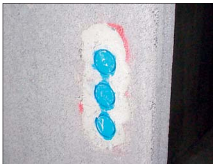
Karpide kinnitamine ACO-elementile müürimördiga
