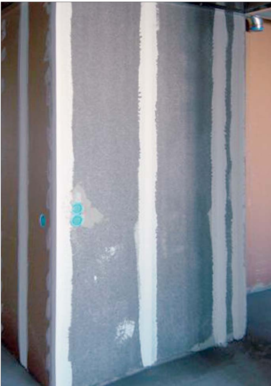
Paberist vuugilintidega kaetud ACO-elementid enne tasandustöid
